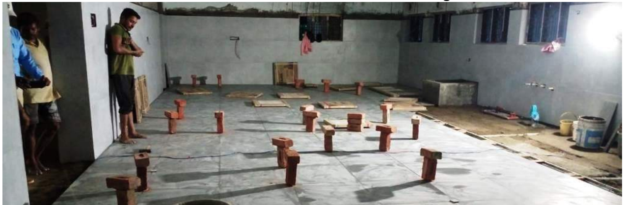
Het tegelen van de vloer.....
