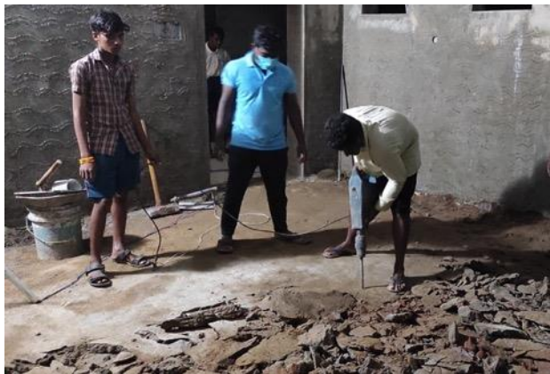
De toiletten worden helemaal afgebroken
