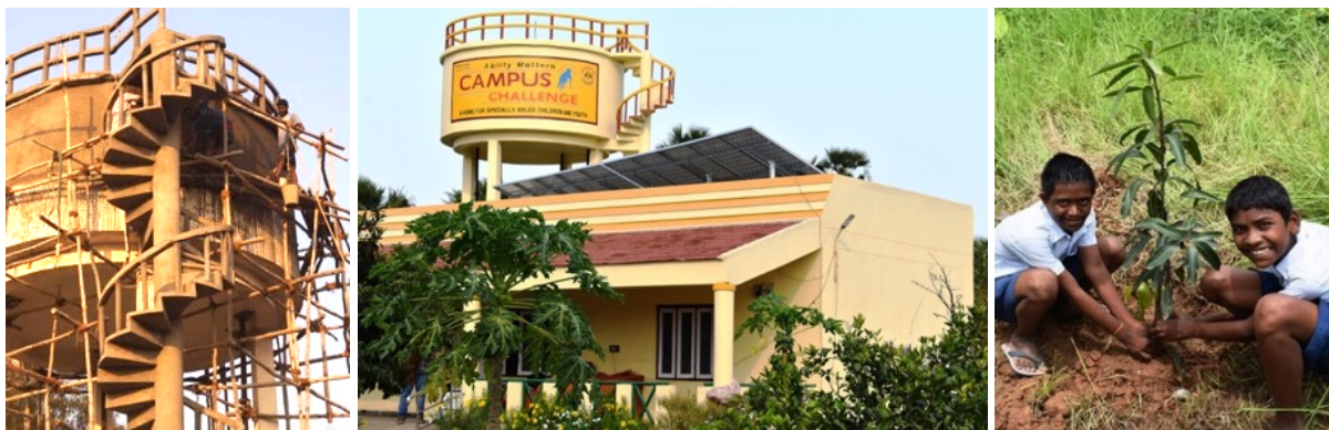
De gerenoveerde watertoren én een waterpomp op solar,
