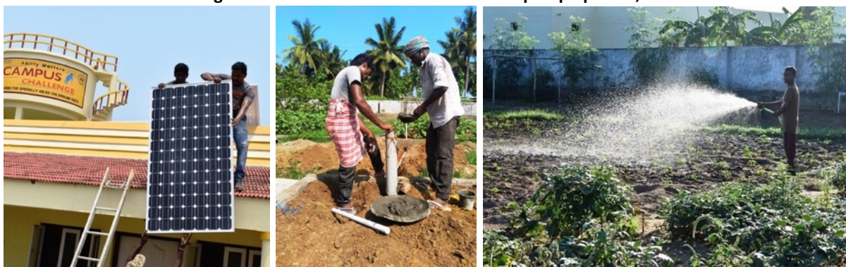
De solarpanelen en de pomp worden geplaatst – en er is water!
