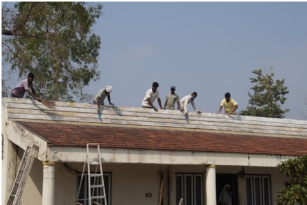
Kinderhuis 1 en 2 in renovatie
