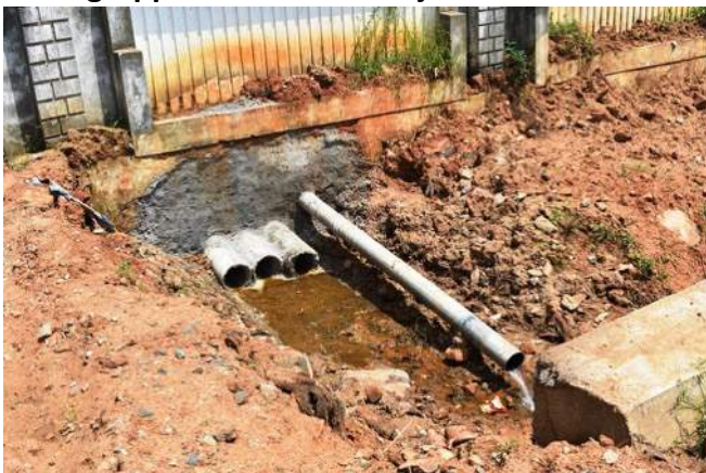
Doorvoer duiker en greppel noordzijde
