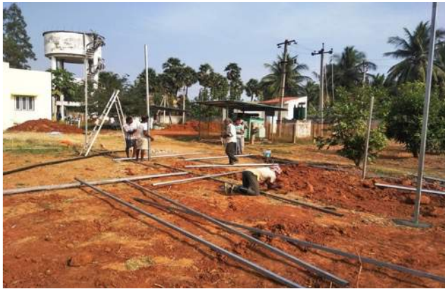
Akker 1: de bouw van de kas begint
