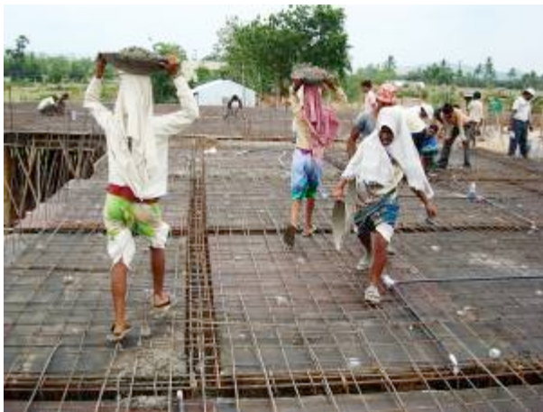
Het dak van het medisch centrum
