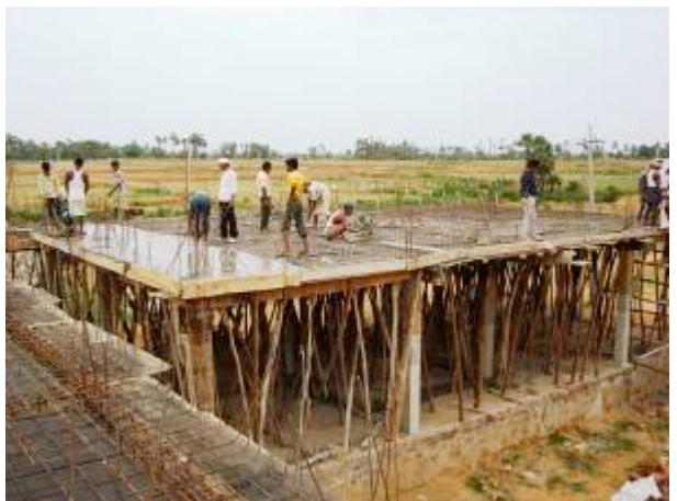
Het dak van de keuken
