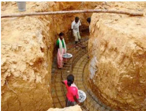
Fundament voor de watertank
