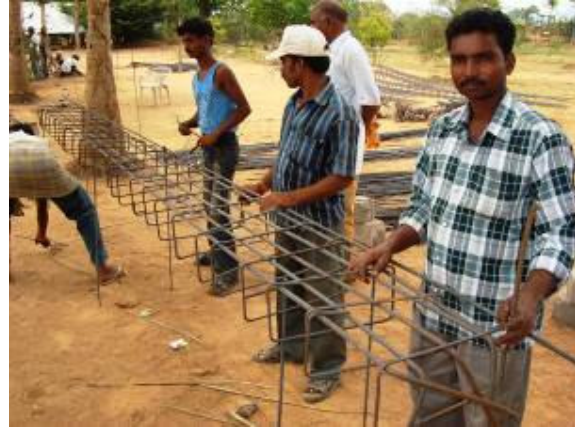
Het vlechtwerk voor de fundering
