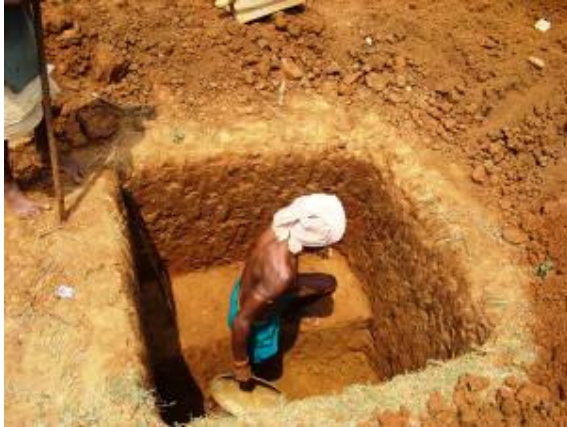
Het graafwerk voor de fundering
