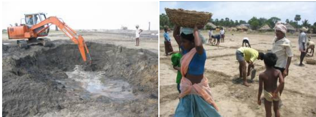
De bronnen worden uitgegraven en de zandlaag wordt verwijderd
