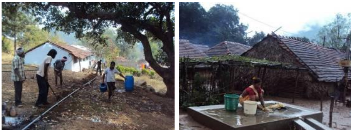
De constructie van een wasplatform
