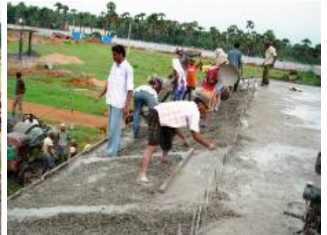
Het beton voor het dak van twee huizen in het kinderdorp wordt gestort
