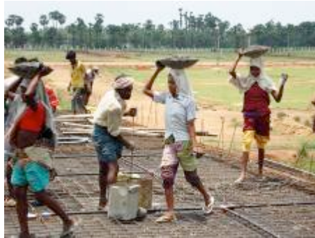
Het beton voor het dak van twee huizen in het kinderdorp wordt gestort
